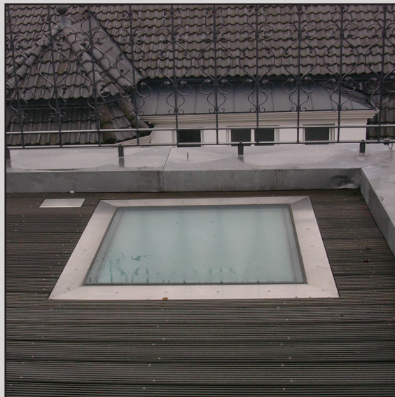
Begehbares Glas im Boden eingelassen
